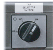
Interruptor para Cambios de Tomas del Transformador
